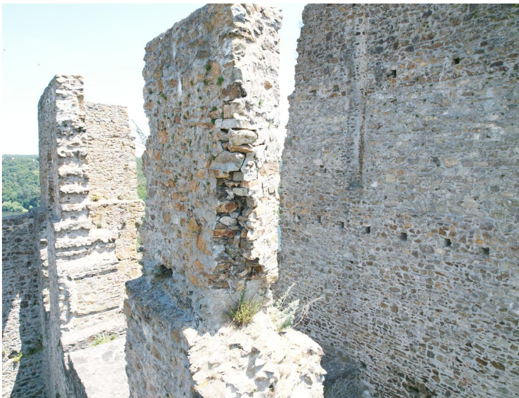
Pohled na trhlinami narušené zdivo hradební stěny.
