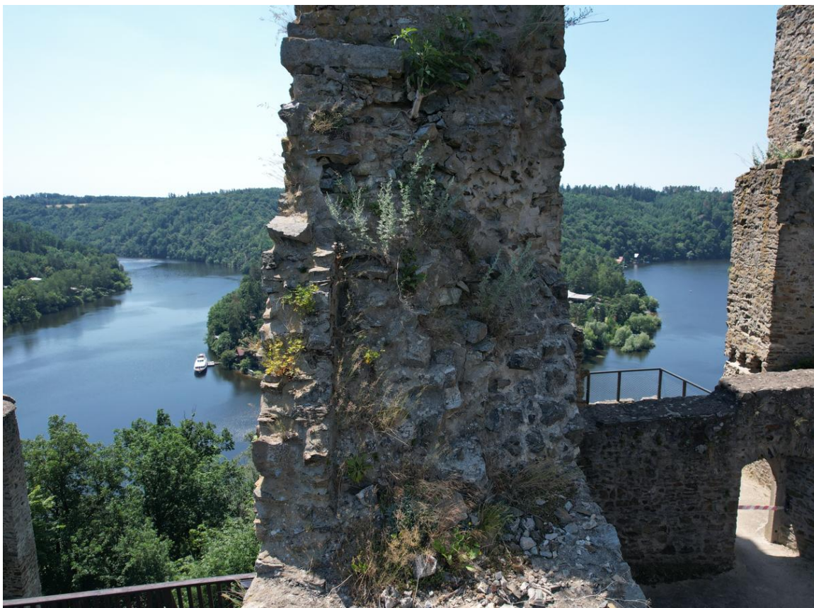
Pohled na nejvíce narušenou patní část zdiva.
