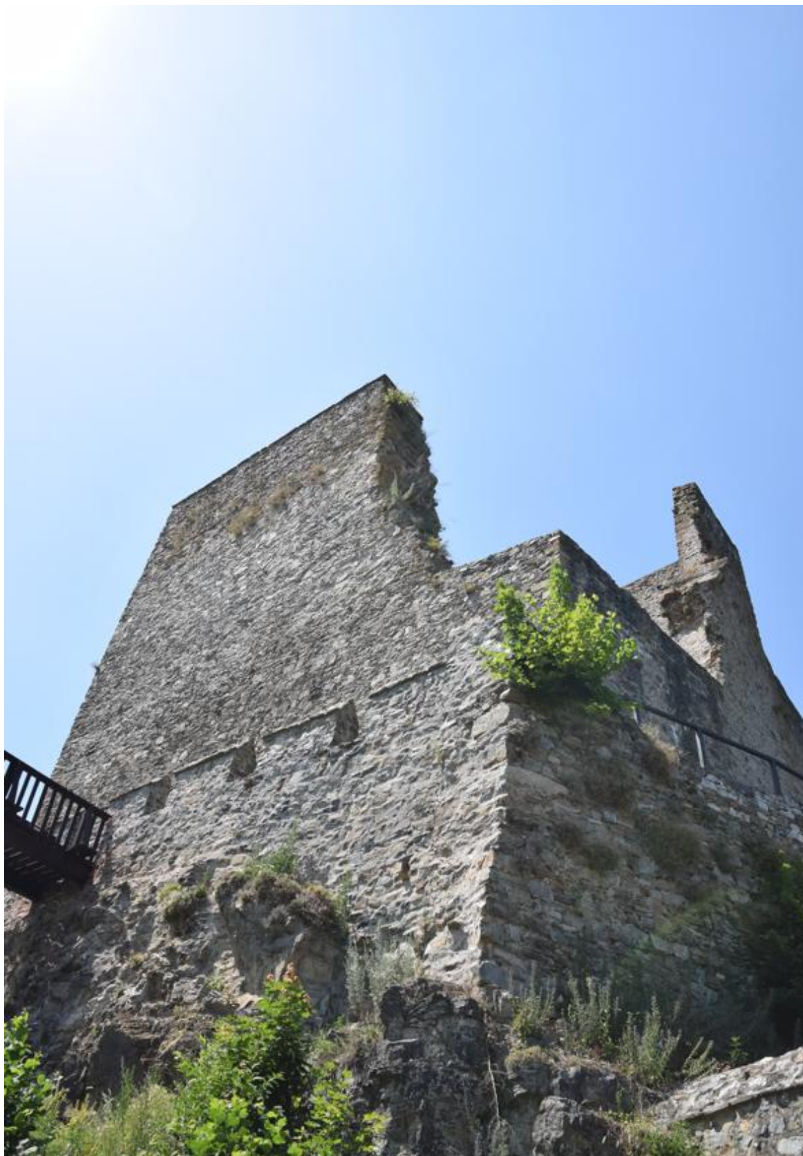
Pohled na nárožní zdivo ochozu, jenž je narušeno kořenovým systémem vzrostlé náletové vegetace.
