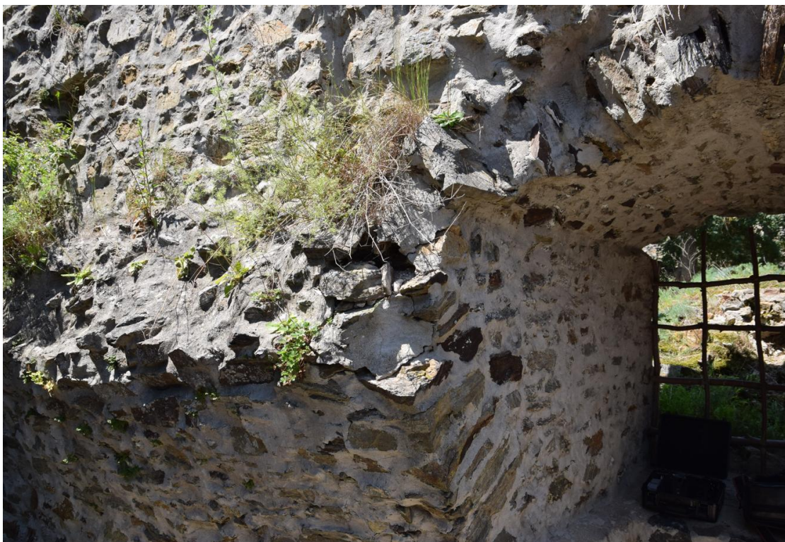
Pohled na narušené ostění okenního otvoru v prostoru pod otvorem s obloukovitým „nadpražím“.
