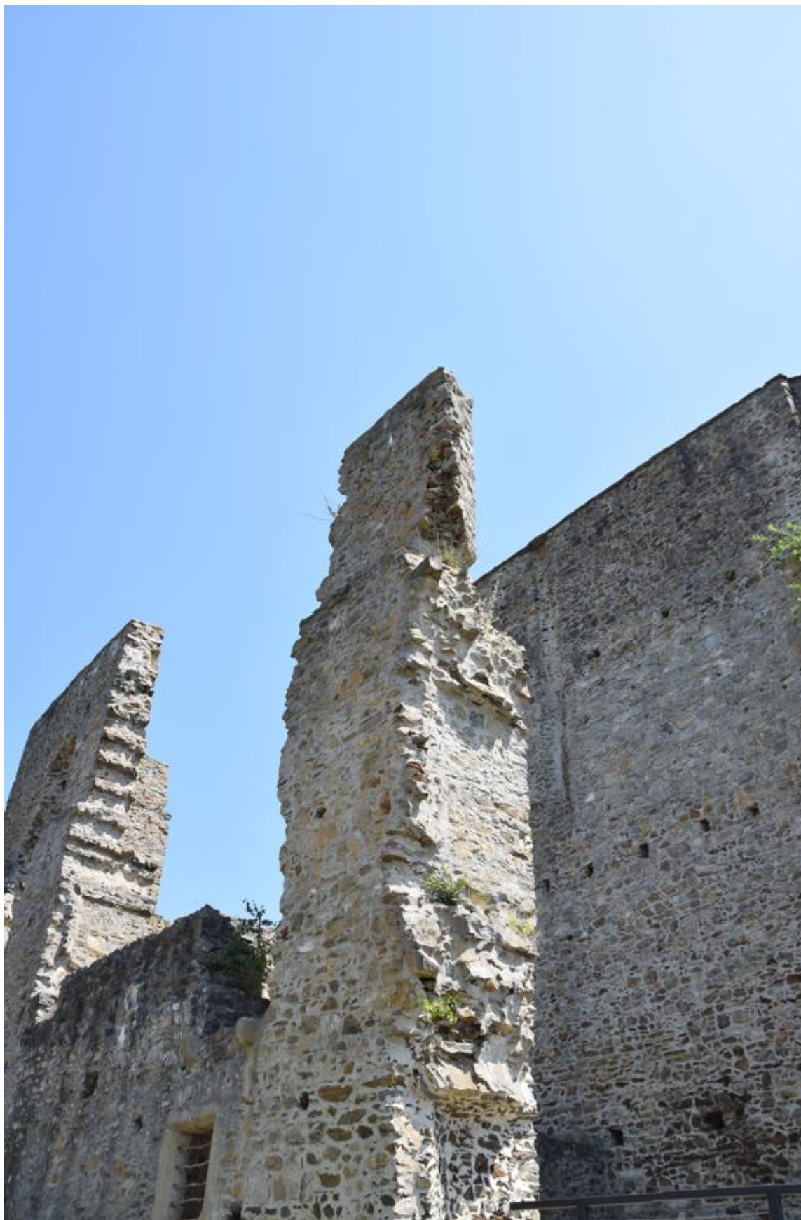
Spodní část reliktu pilíře zdiva je také narušena mírným rozpadem zdiva.
